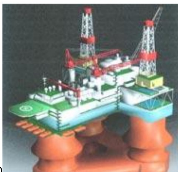
Рис.3. Морские стационарные ледостойкие гравитационные платформы, разработанные ЦКБ Коралл для месторождения «Аркутун-Даги»: а) вариант с одноопорным основанием; б) вариант с трехопорным основанием
